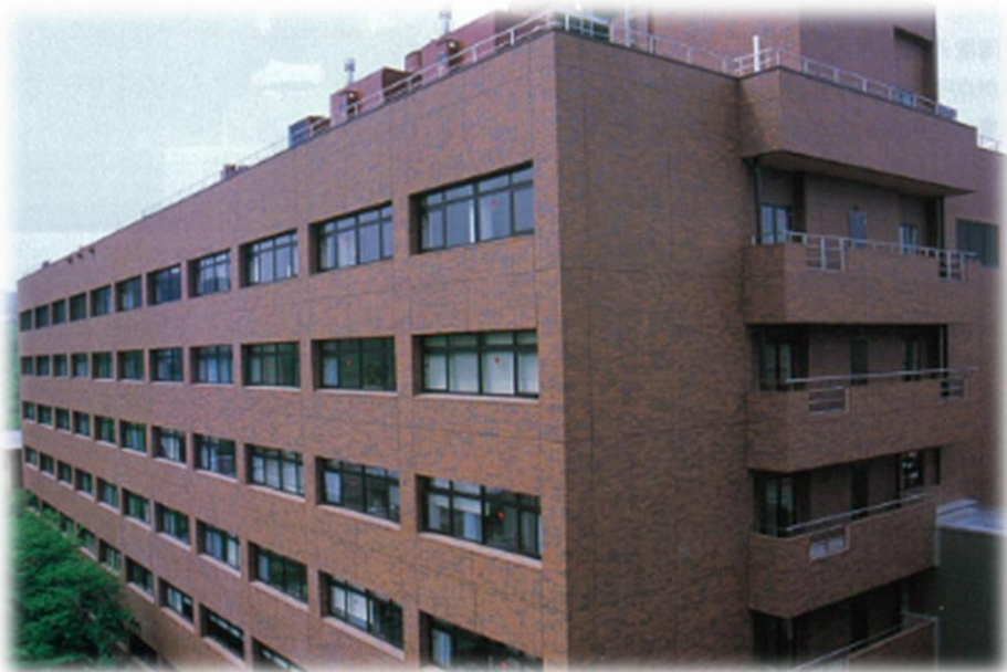
平成14年(2002)3月に竣工した新病棟 (D館)
